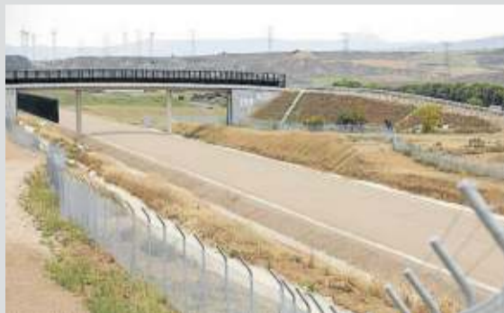
Obras del TAV, ayer cerca de Falces. Foto: Unai Beroiz
